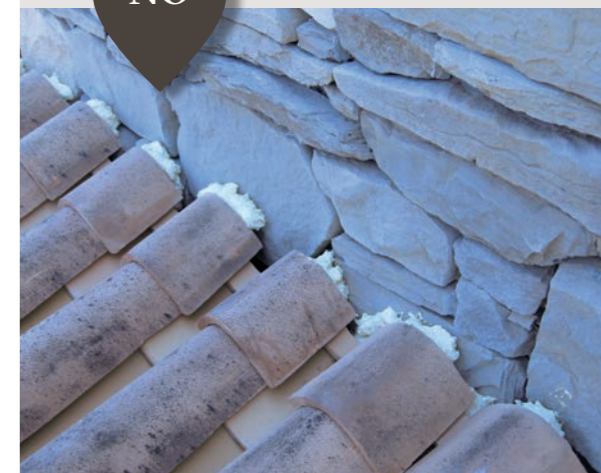
Nella fotografia un esempio di errata posa
