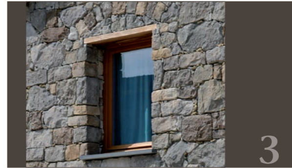
architrave finestra con listello di sostegno
