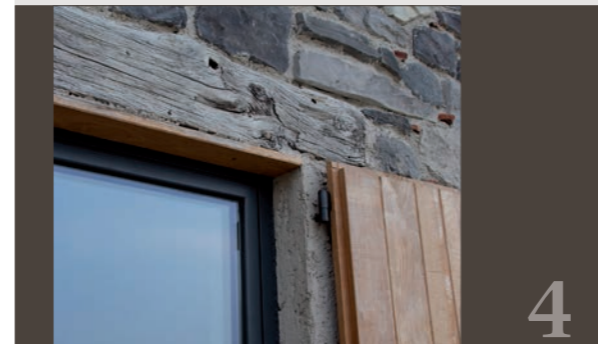
architrave finestra con trave in legno
