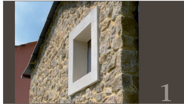
contorno finestra con cornice rasata e colorata
