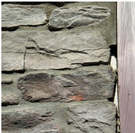
Nella fotografia si nota la spaccatura creatasi per le grosse tensioni causate da una errata sottostruttura con montanti in legno a cui sono state fissate lastre in fibrocemento in una struttura ventilata.
