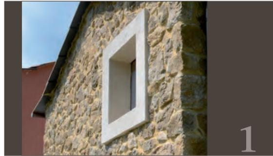
Per finiture di aperture di porte e finestre ad intonaco, è necessario applicare una cornice dello spessore di circa 6 cm in modo da nascondere lo spessore della pietra. Per la realizzazione di suddetta cornice è possibile utilizzare ritagli di materiale isolante incollati sul cappotto con collante specifico, quindi rasare annegando la rete di armatura. Rifinire con intonaco pigmentato.
