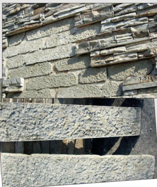
**10. ERRATA POSA CON SPATOLA DENTATA** e stesura di Geocoll® solo sul fondo, con semplice appoggio del pezzo nello stile "posa piastrelle ceramiche". L'aggrappo rimane insufficiente a contrastare le forze dovute alle diverse dilatazioni termiche tra rivestimento e fondo portante. Manca la doppia spalmatura del collante, sul pezzo e sul fondo, per una posa fresco su fresco.
