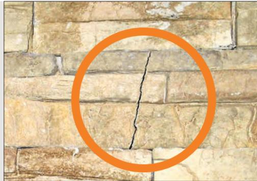
**2. ERRATA POSA SU RASATURA.** Sopra una superficie con intonaco plastico è stata eseguita una rasatura gesso e in seguito è stata incollata la pietra, senza doppia spalmatura del collante. Il risultato è stato uno stacco completo del rivestimento (si notino gli aloni lasciati dal collante nella parte bassa della foto). La prova di strappo eseguita successivamente dimostra contemporaneamente la pericolosità di tale fondo e l'efficacia di tenuta del collante Geocoll®.
