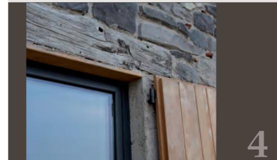
Il semplice inserimento di una trave decorativa soddisfa, seppur solo visivamente, la richiesta di sostegno del muro sovrastante l'apertura di porte e finestre e dà pieno credito all'opera. Applicare un trave in legno segato allo spessore di 5/6 cm, nella parte superiore dell'apertura e rivestire il resto del contorno con materiale isolante. Per il fissaggio dei cardini di eventuali ante prevedere l'utilizzo degli appositi supporti di montaggio che vanno applicati prima della posa del cappotto.
