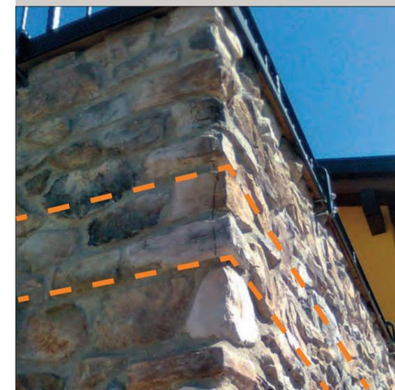
Nella fotografia si può notare la rottura degli angoli a livello della soletta portante, dove un pannello OSB era stato **avvitato direttamente sul trave lamellare orizzontale**. Quest'ultimo dilatando ha innescato forze sufficienti a rompere la pietra incollata nella sua parte terminale.
