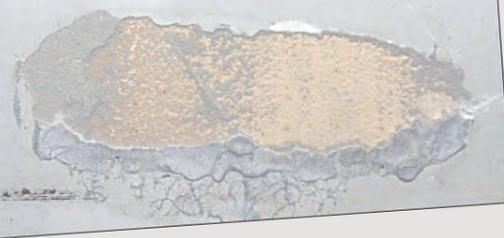
**3. ERRATA POSA SU LATERIZIO IN ESTERNO** le strutture soggette ad intemperie, normalmente non sono eseguite con materiale assorbente. Il caso illustrato mostra le conseguenze di un rivestimento collocato su fondo in laterizio posto all'esterno.
