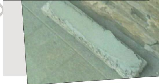
**4. ERRATA POSA SU RASATURA FRESCA.** La posa avvenuta su cartongesso con rasatura di collante continua e non stagionata ha determinato lo stacco completo della pietra e del collante. Quando si effettua una rasatura di fissaggio sul fondo, non risulta possibile effettuare l'incollaggio fino a suo completo indurimento.
