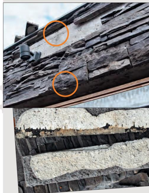
**12. STACCO IN PRESENZA DI PELLICOLA DI FINITURA**. L'utilizzo di un trattamento di superficie impermeabilizzante e non di un impregnante di profondità ha causato lo stacco, manca inoltre la doppia spalmatura con Geocoll®. (Vedi cap. 6 preparazione fondi)
