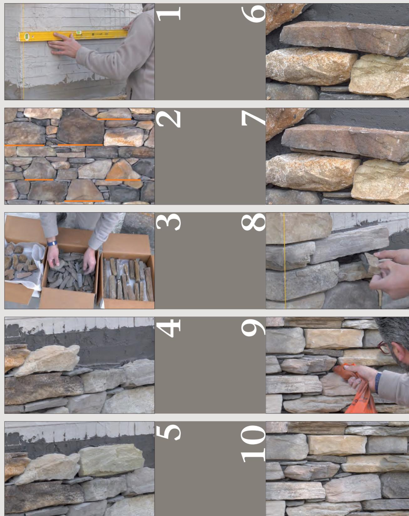
Una piccola lavorazione dei bordi molte volte è necessaria, se possibile cercare comunque di mantenere l'integrità della forma della pietra. Se si rilevasse la necessità di migliorare la stabilità visiva della pietra successiva, inserire un pezzo **GeoFit** nella forma appropriata (dalla fig.4 alla fig.8). Diversamente proseguire con le pietre senza preoccuparsi degli eventuali spazi vuoti rimasti.
