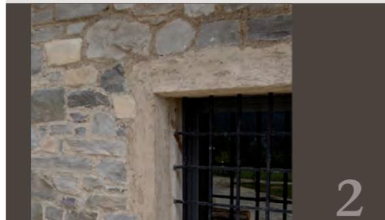
Per ottenere spalle rasate a filo pietra, rivestire il contorno della finestra con materiale isolante. Incidere poi con il cutter la cornice per inserire la pietra in modo che una volta stuccata con la malta risulti incassata a filo. Sullo spigolo così ottenuto è possibile fissare i cardini delle ante avendo predisposto prima della posa del cappotto gli specifici supporti di montaggio.
