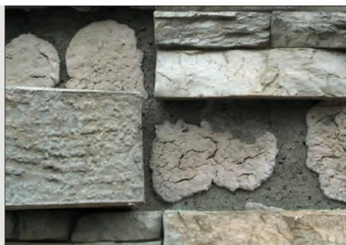
**8. ERRATA POSA "A PUNTI" SU CEMENTO ARMATO**, in inverno con temperatura del muro vicina o inferiore a 0°C e presenza di velo d'acqua dovuto al lavaggio con idropulitrice del fondo e incollaggio senza attendere l'asciugamento. Lo stesso inconveniente può avvenire in presenza di **disarmanti, trattamenti impermeabilizzanti o aggrappanti con formazione di pellicola**. Manca la doppia spalmatura del collante, sul pezzo e sul fondo, per una posa fresco su fresco.
