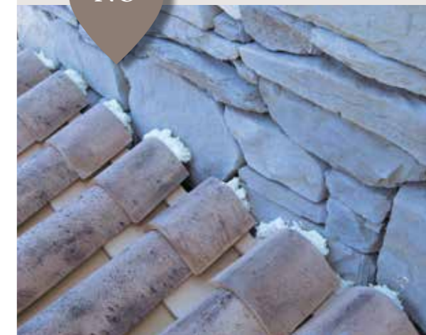
Nella fotografia un esempio di errata posa
