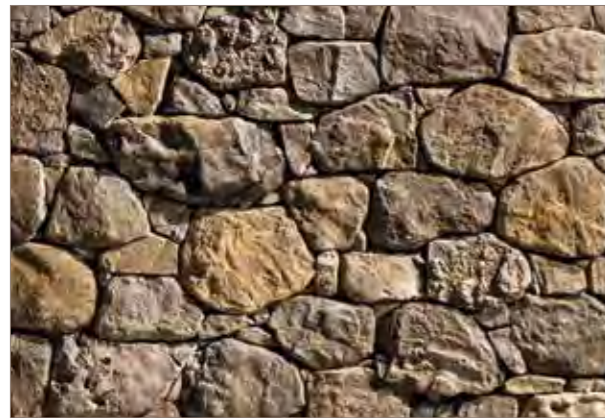
fuga a secco
